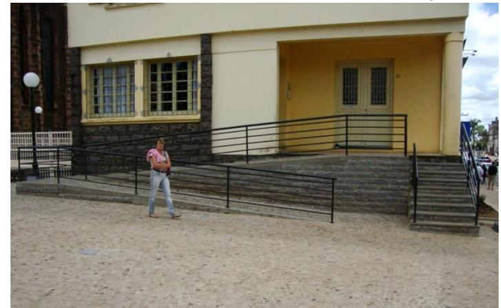
Os equipamentos comunitários podem adotar esse modelo. Rampas para PNEs e passeio com piso diferenciado e alargado.
