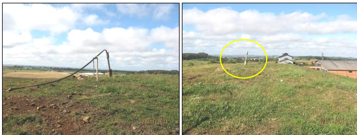
Fotos 4.17 e 4.18 - A injeção do efluente tratado no aterro antigo se dá através de um dreno de gás.
