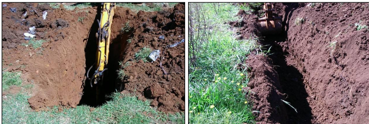
Fotos 4.1 e 4.2 – Sondagens realizadas em 2006, com a utilização de retro escavadeira.
