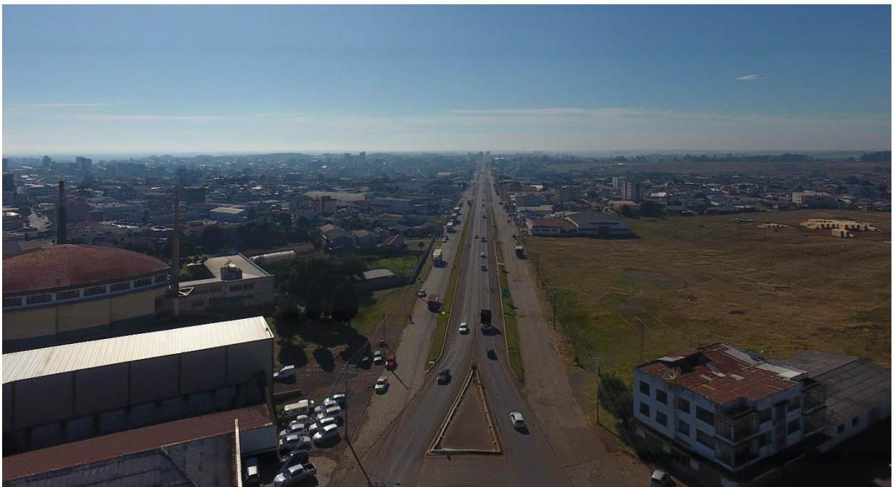
Figura 4: Vista pista BR 116 no sentido Divisa RS/SC
