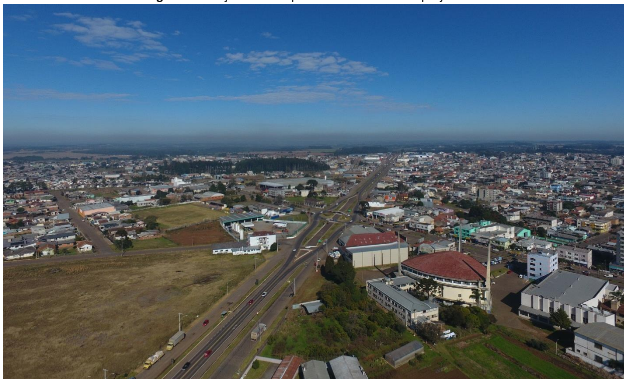
Figura 2 – Interseção o km 39+340 da BR 116 – local de implantação do projeto da OAE
