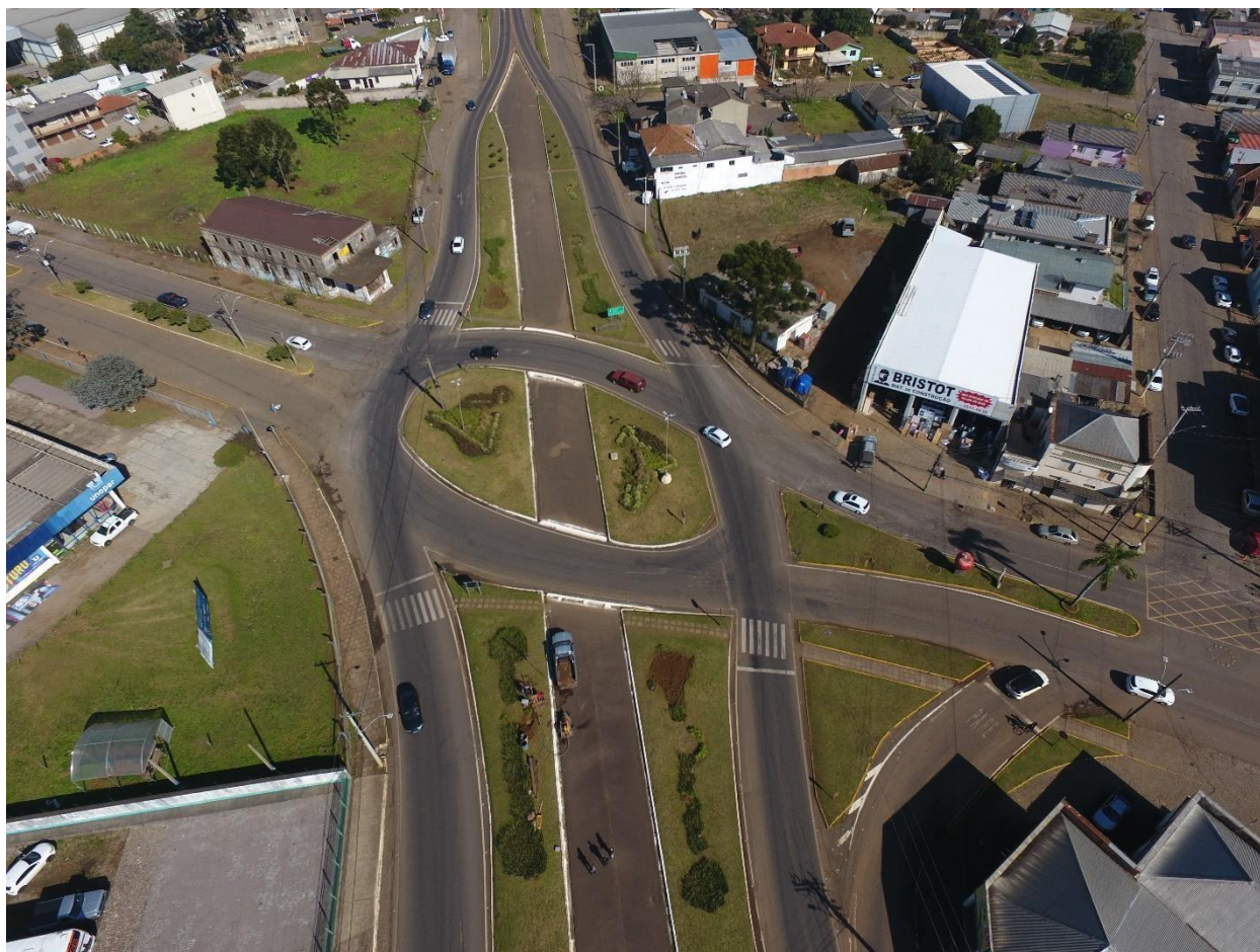
Figura 5: Interseção existente no km 39+340 (BR116 x Av. Moreira Paz)
