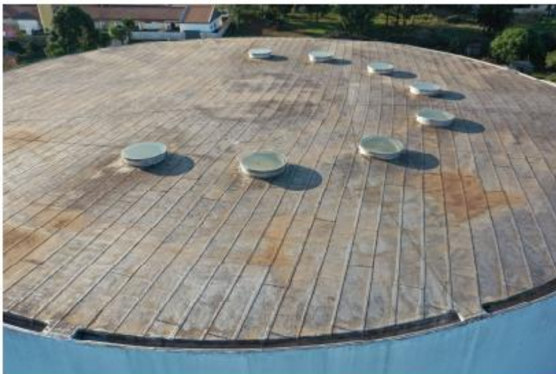
FIGURA 13: Vista superior laje de cobertura
