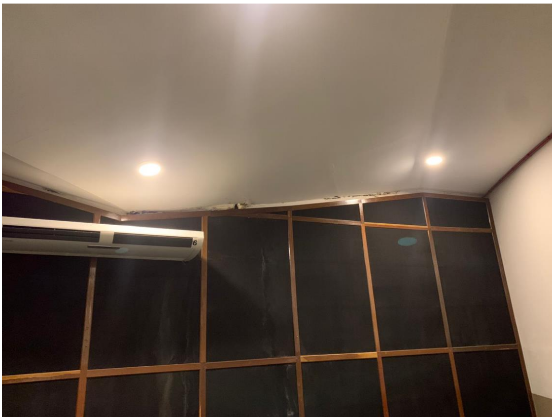
FIGURA 7: Rebocos desprendidos e mofos
