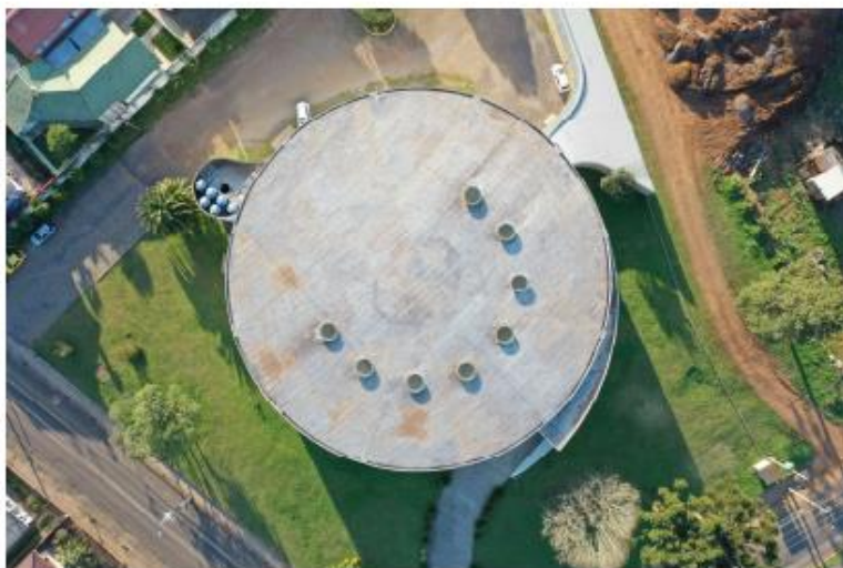
FIGURA 09: Vista superior laje de cobertura
