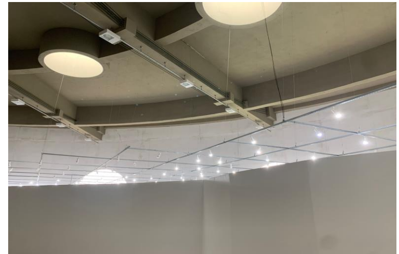
FIGURA 3: Rebocos desprendidos, trincas e fissuras.
