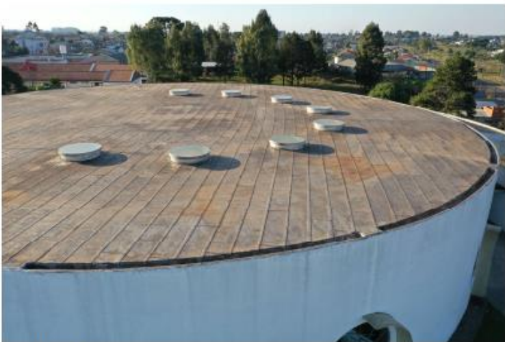
FIGURA 12: Vista superior laje de cobertura
