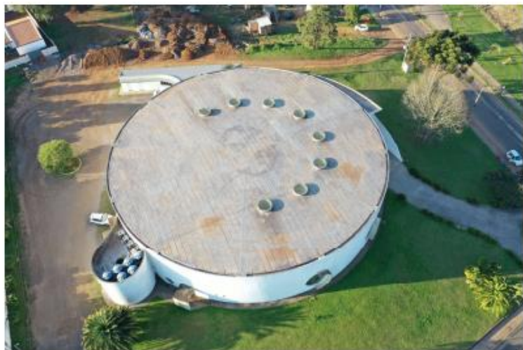
FIGURA 10: Vista superior laje de cobertura
