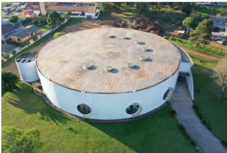
FIGURA 11: Vista superior laje de cobertura
