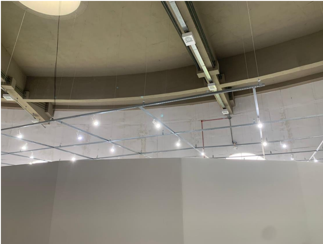
FIGURA 4: Trincas e fissuras.
