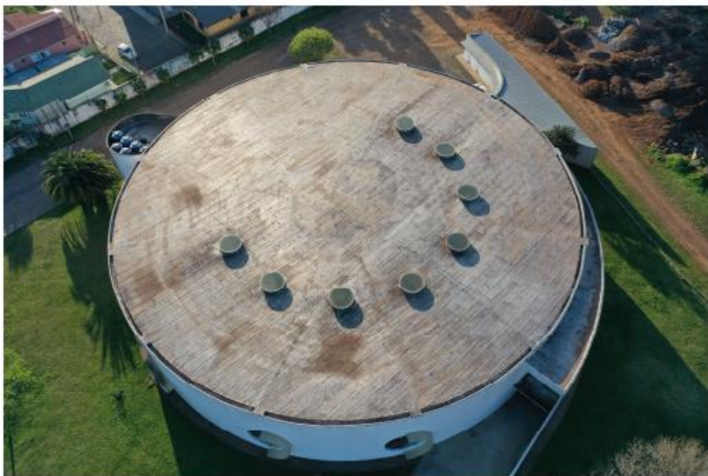
FIGURA 08: Vista superior laje de cobertura
