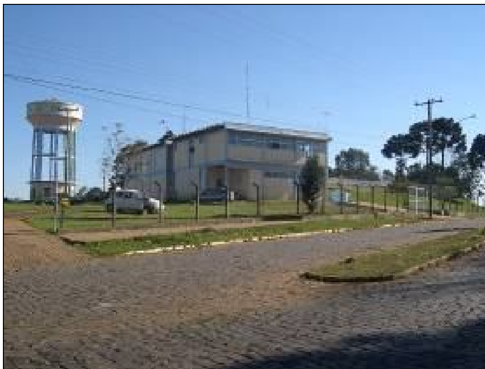
Vista da geral da Estação de Tratamento de Água
