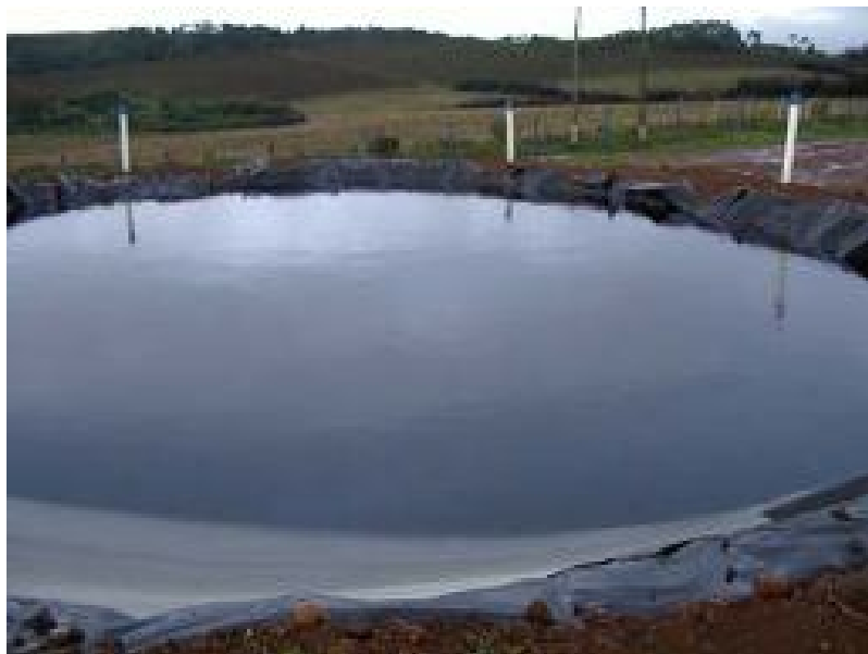
Figura 22 – Tratamento de efluentes percolados do aterro sanitário
