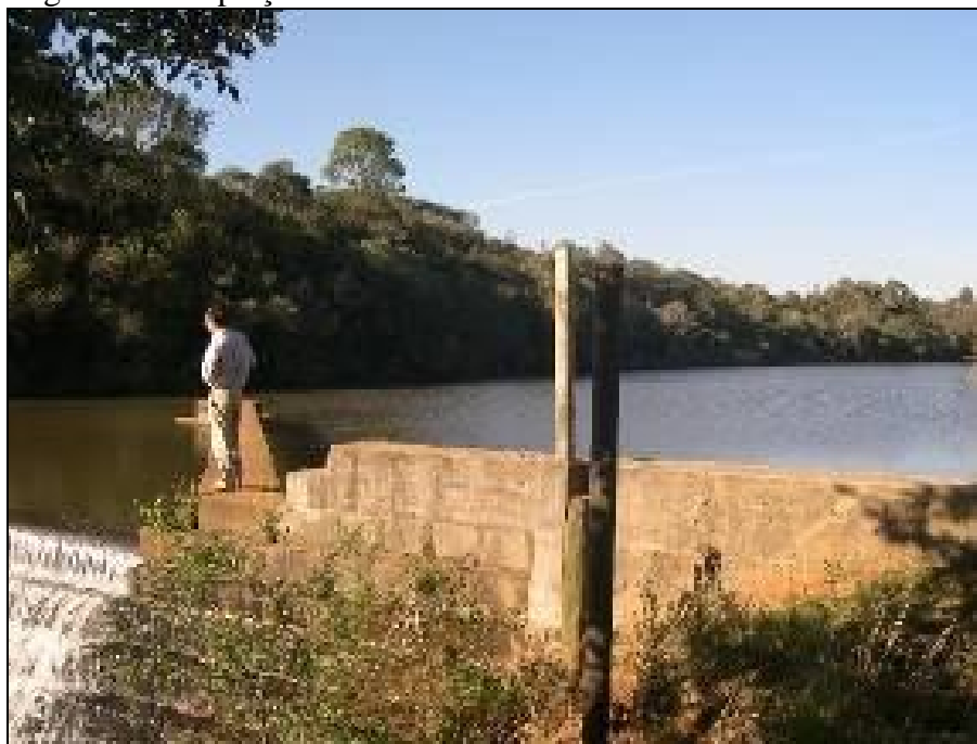
Vista da barragem de nível
